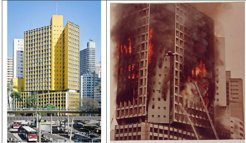
Figura 05 – Incêndio no Ed. Joelma
