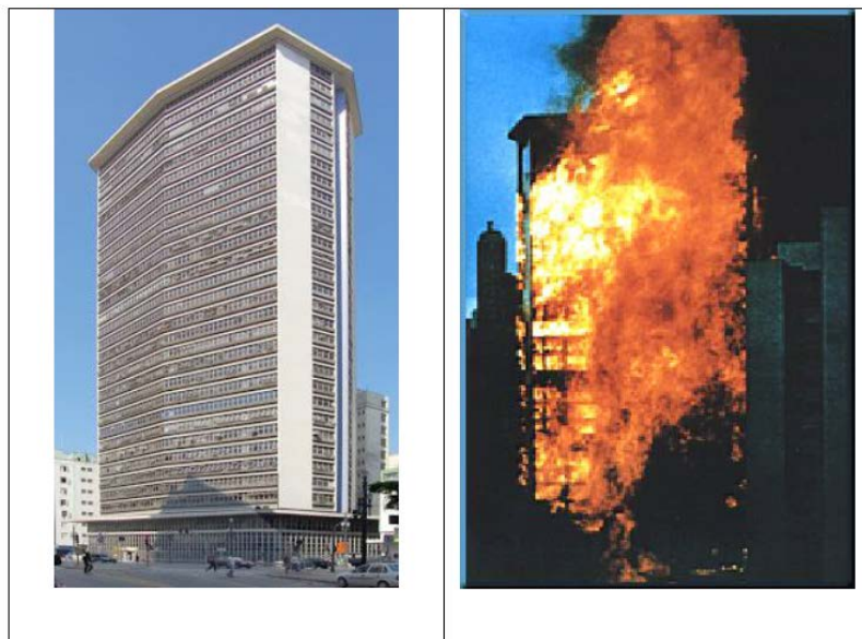
Figura 04 – Incêndio no Ed. Andraus
