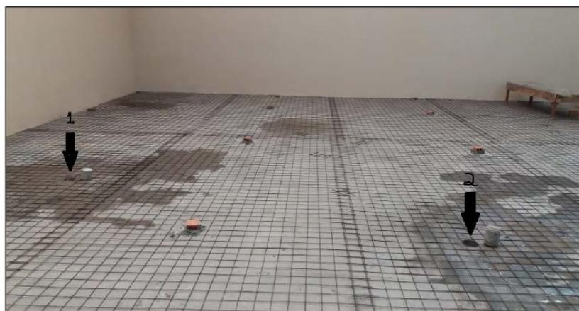
Laje por sua vez possui altura efetiva de 11cm e armadura de distribuição com diâmetro de 10mm a cada 18cm nas duas direções.
